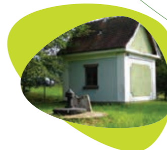
Station de pompage de Montreux-Vieux
